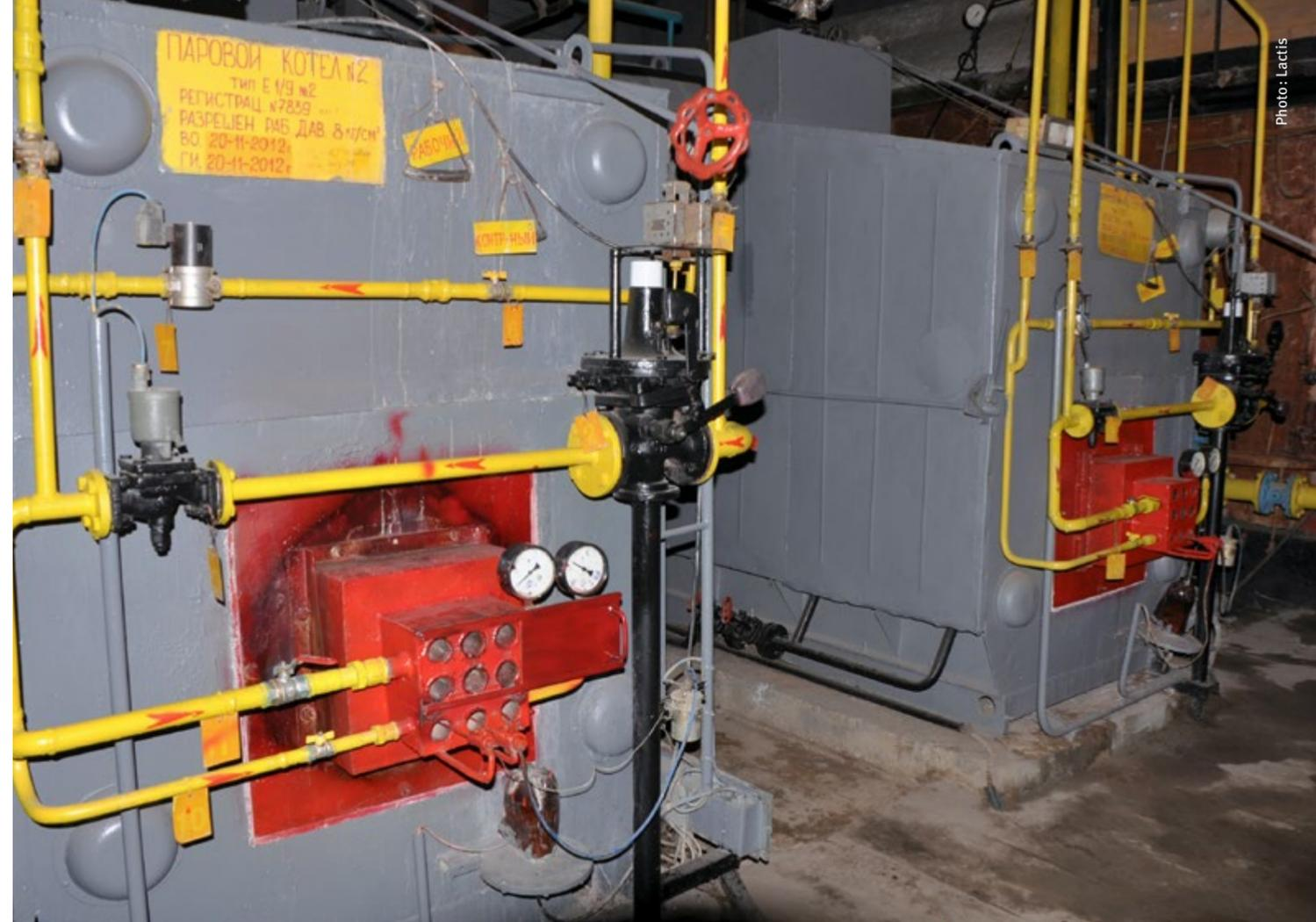
通过安装手动阀门改进锅炉的进气量，这样只使用一台锅炉就够了。
