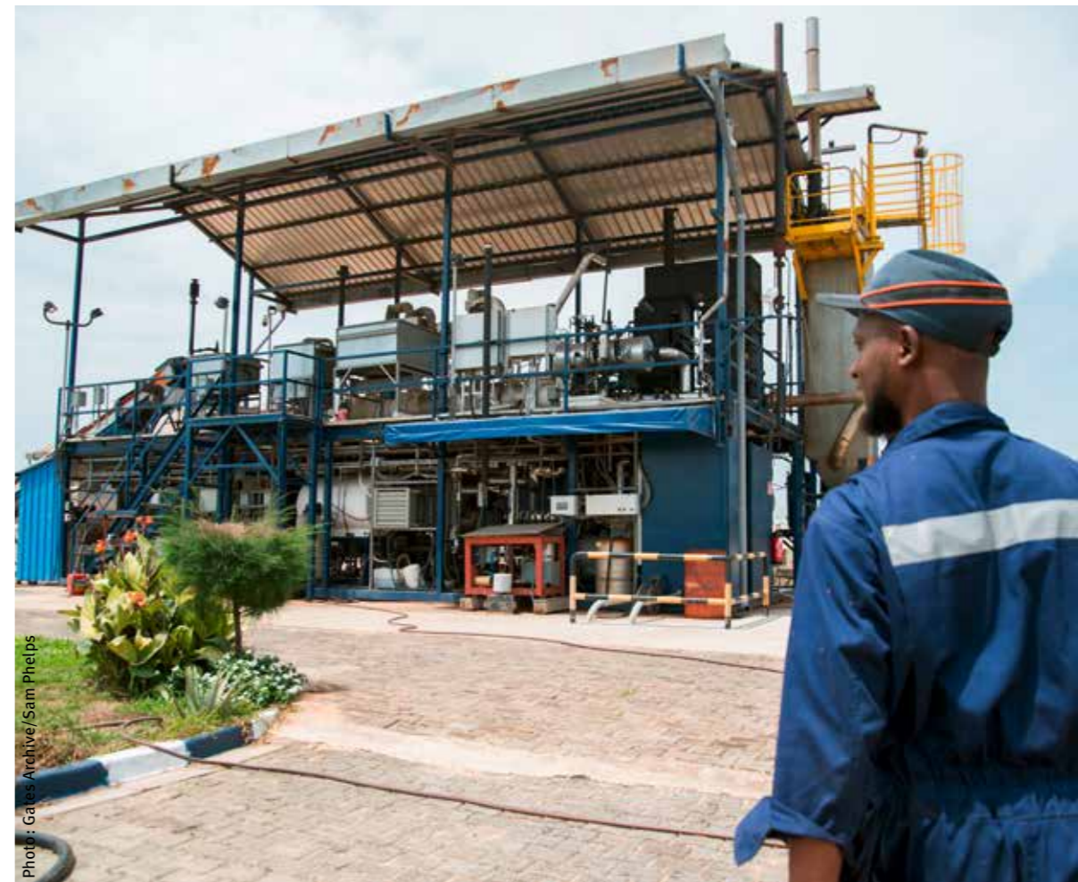
Installé à Dakar, au Sénégal, en 2015, l'omniprocesseur de Janicki Industries traite désormais les matières de vidange générées par près de 100 000 personnes.
