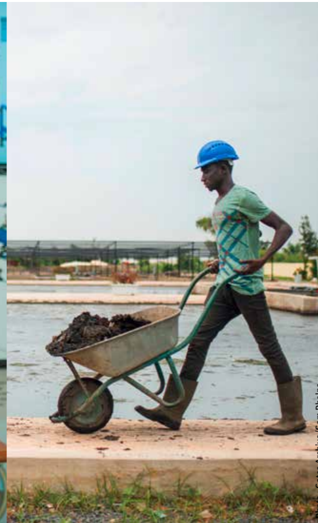
Les matières de vidange sont transportées jusqu'à l'omniprocesseur en vue de leur traitement.
