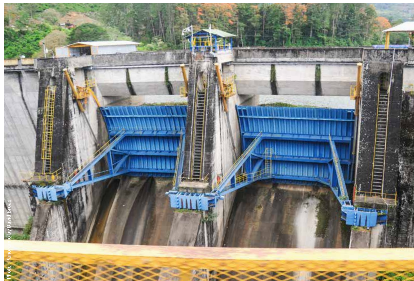
Après des travaux d'agrandissement, la centrale hydroélectrique de Cachí peut désormais produire près de 160 MW.
